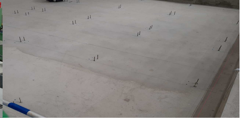
(アンカー打設)
