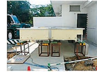
各配管の取り付け
