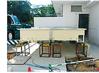
各配管の取り付け
