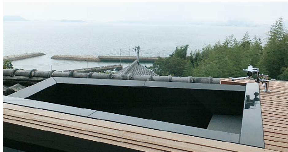
宿泊施設 仕様/ 框：黒御影石 内側：御影石 寸法/1,800×1,100×H600mm (内寸 1,600×900×H520mm)
