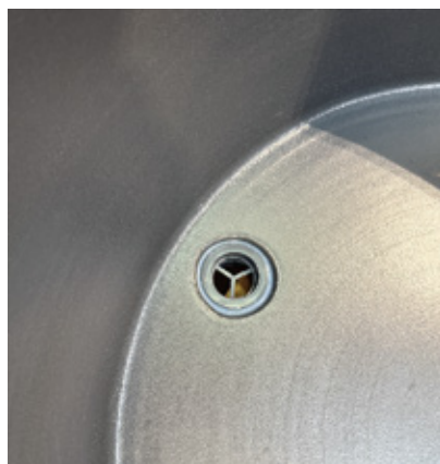
排水穴の様子
