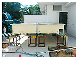
各配管の取り付け
